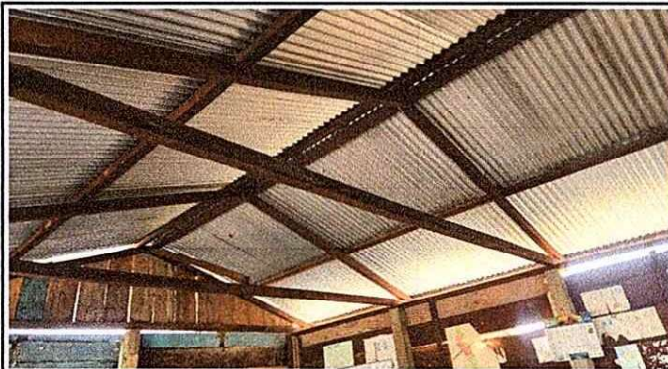
Foto 2: Sustitucion de Estructura de techo por metal
