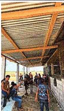
Foto 3: Entortado de concreto liso
