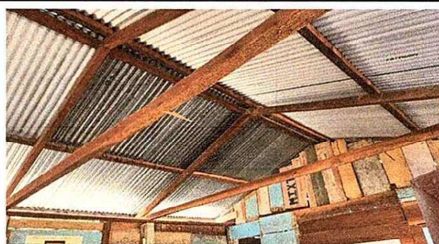
Foto 4: Sustitucion de Lamina
