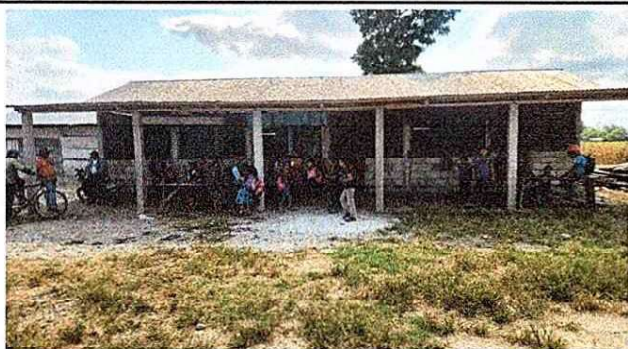
Foto 1: Sustitucion de lamina
